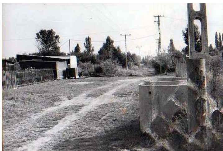
Rege utca, 1980. október – csatornahálózat építése
