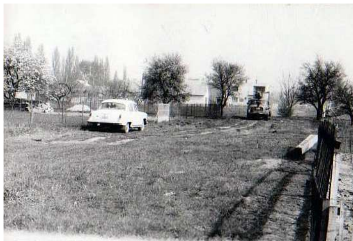
Rege utca, 1980. – villanyhálózat kiépítése
