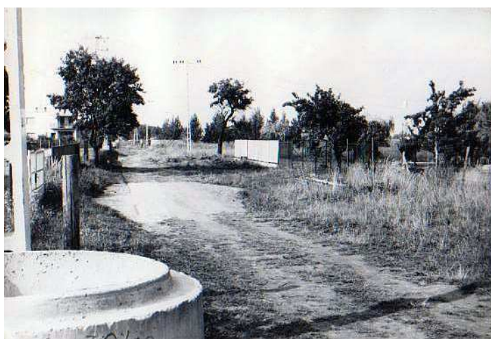
Rege utca, 1980. október – csatornahálózat építése
