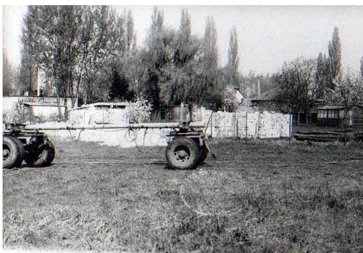
Rege utca, 1980. – villanyhálózat kiépítése
